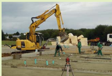
Remblaiement entre les longrines
