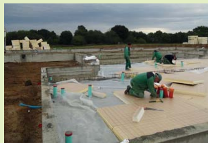
Pose de l'isolation sur la dalle portée
